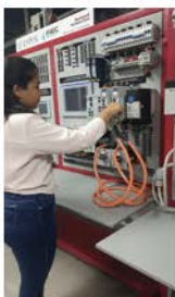
5.- Revisar las conexiones de control y fuerza del servodriver .
