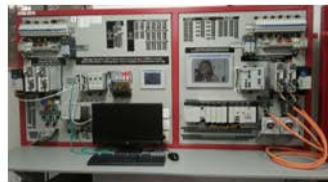
2.- Revisar los equipos y componentes del tablero.
