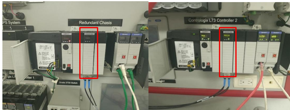
Ilustración 53. Redundancia del Controlador Primario.
