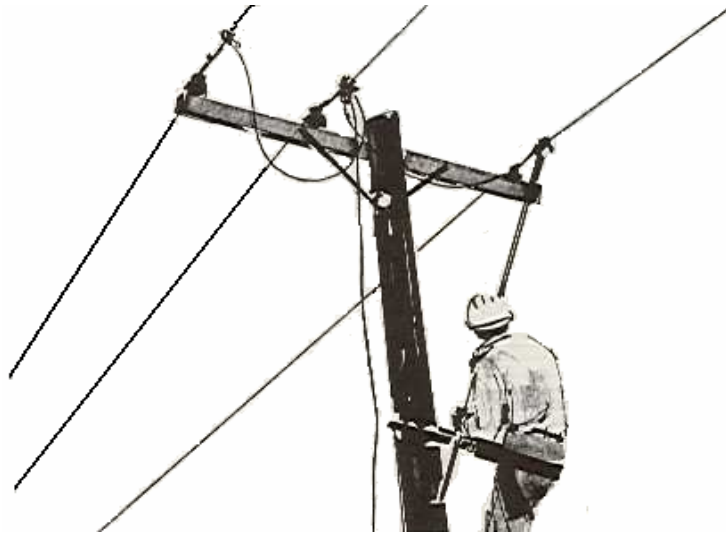
Figura 14. Puestas a tierra para protección del personal
