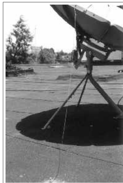
Tensor o viento de antena
